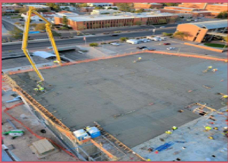
Level-4 Area 10 Concrete Pour
