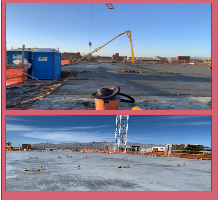
Level-4 Area 10 Concrete Pour
