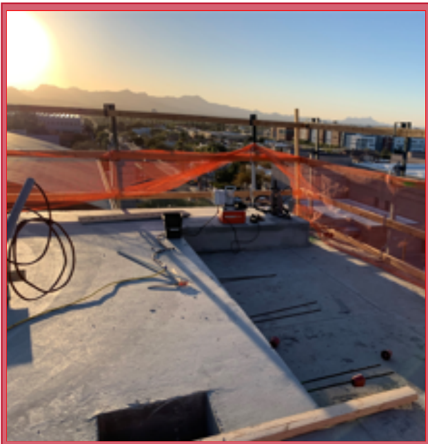
Post Tension Slab Edge
