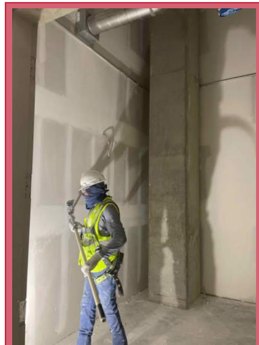
Drywall Taping
