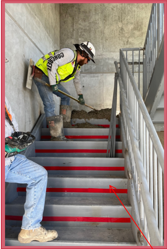
Stair #2 - Pan Pour
