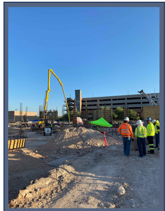
First vertical pour on site!
