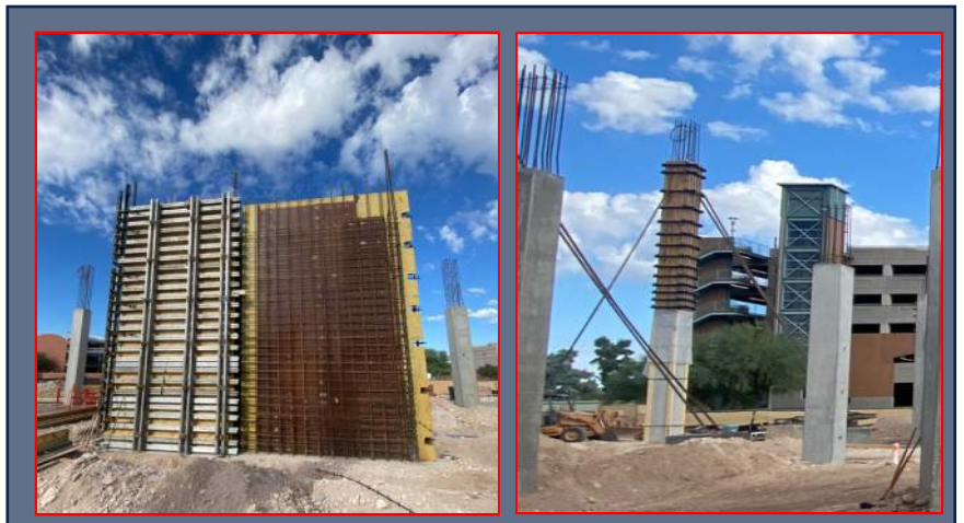
Core Wall-1 & High-Bay Columns Prep for Pour
