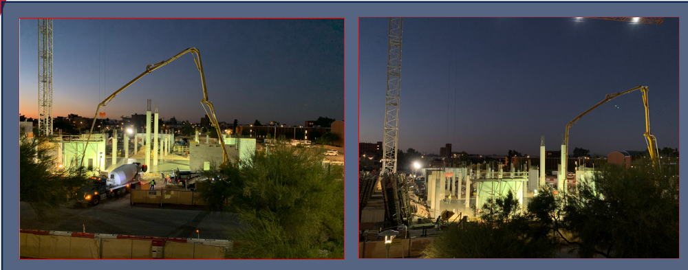
Early Morning NE Corner Slab On Grade Pour
