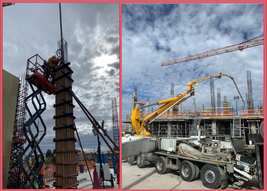
Pumping Concrete to Pour L2 Columns
